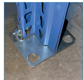
Dos puntos de anclaje al suelo en cada pilar
